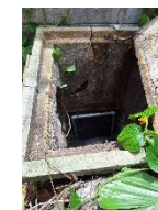
ตะแกรงดักขยะ บ่อพักสุดท้าย
